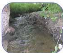
Après travaux : Faciles courant et granulométrie grossière dégagés en amont de l'embâcle.
