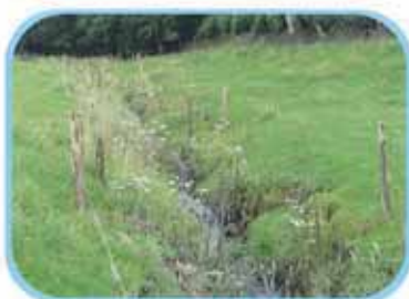
Vallée aux Berges : Clôtures bordant le ruisseau, après chantier.
