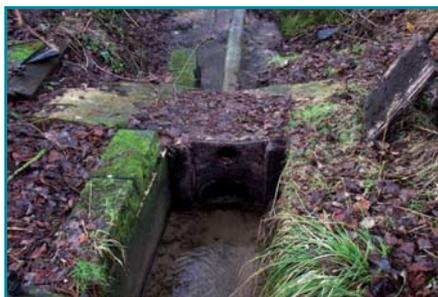
L'intervention à la pelle mécanique, nécessaire pour dégager la partie bétonnée de l'ouvrage, a été réalisée au mois de juillet. C'est la période durant laquelle les matières mises en suspension sont le moins préjudiciables aux milieux aquatiques et aux organismes vivants.
