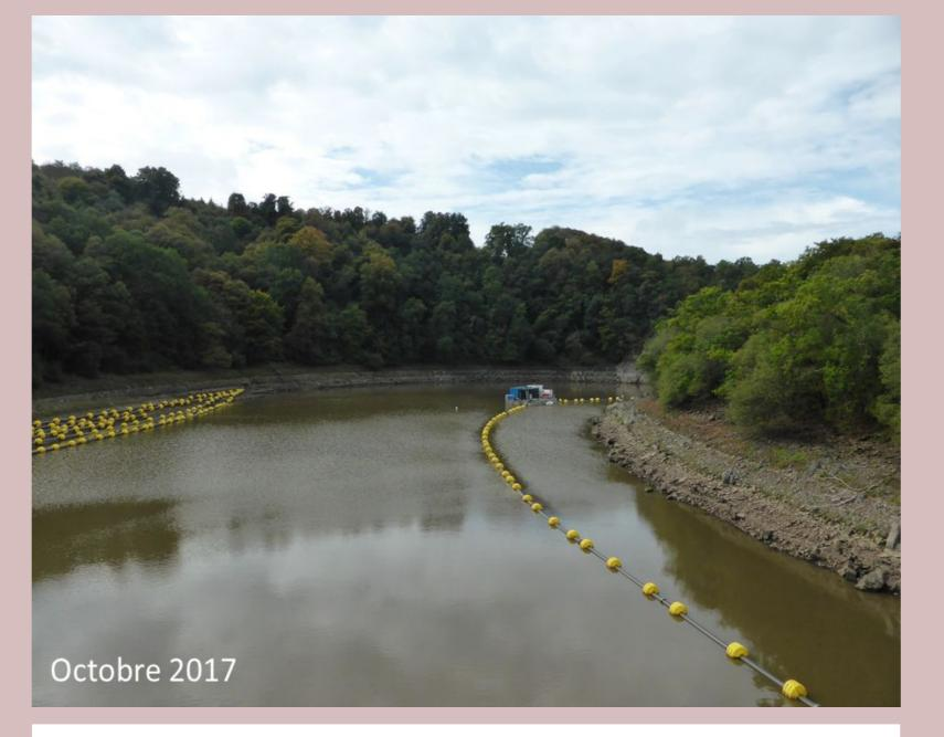
L'abaissement du niveau d'eau de 6m a permis les terrassements terrestres en amont et la gestion des sédiments de l'Yvrande. Les tuyaux flottants conduisent les sédiments fluides de la zone de dragage à la zone de stockage.
