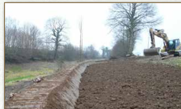
Pour ériger le talus, la terre est prise directement dans le champ sans que cela ne réduise la fertilité.
