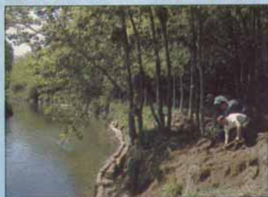
Travaux au confluent de la Sélune et de l'Oir voici quelques jours.
