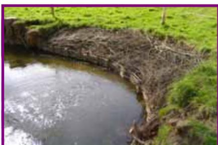
Mise en place d'un tressage et d'un peigne à l'endroit de la poche d'érosion
